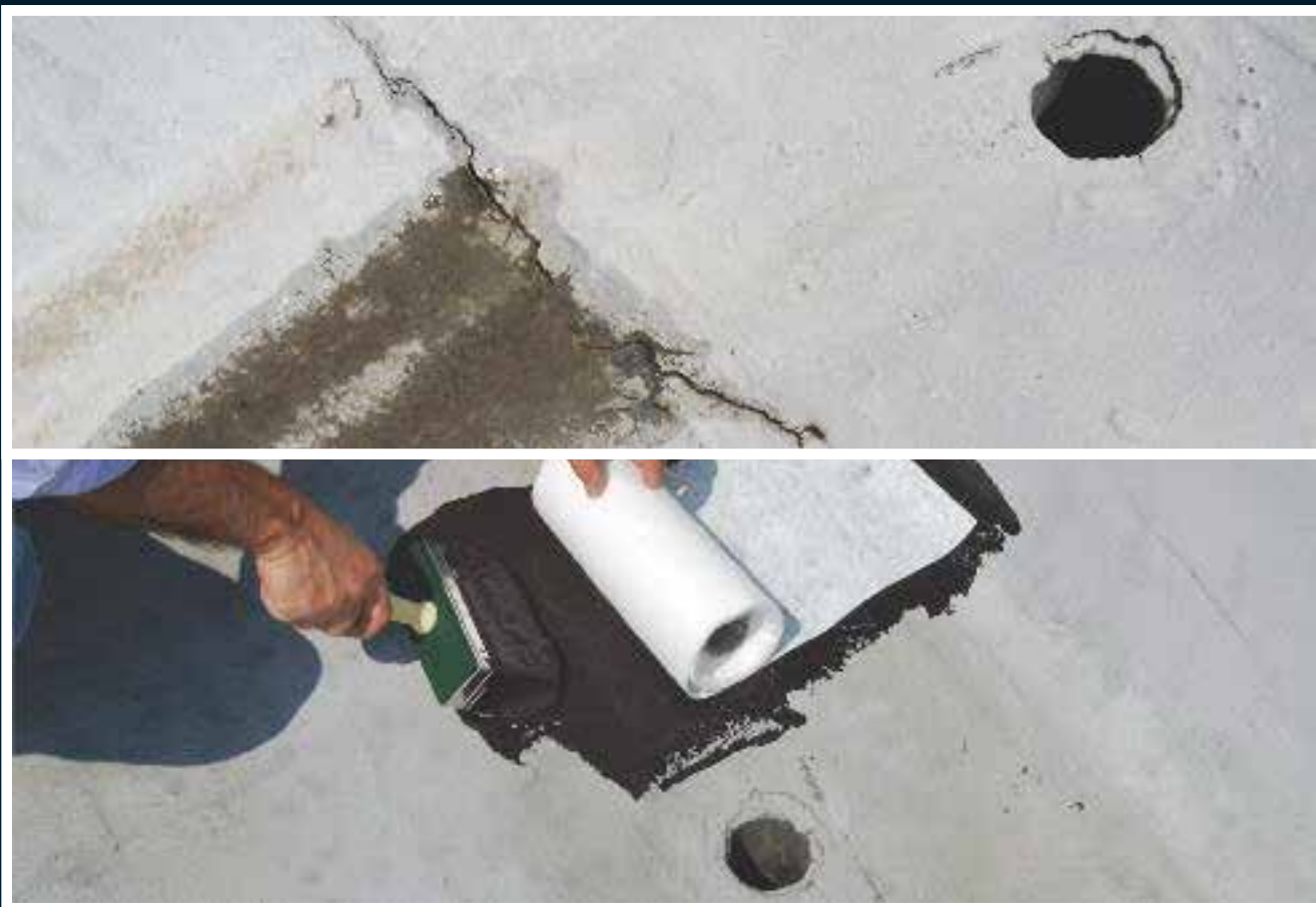
Popravilo razpok (na sliki je popravilo razpoke na bitumenski kritini v bližini iztočne odprtine z uporabo Elastika in Supporto Antifessura – blaga za krpanje lukenj-razpok).
