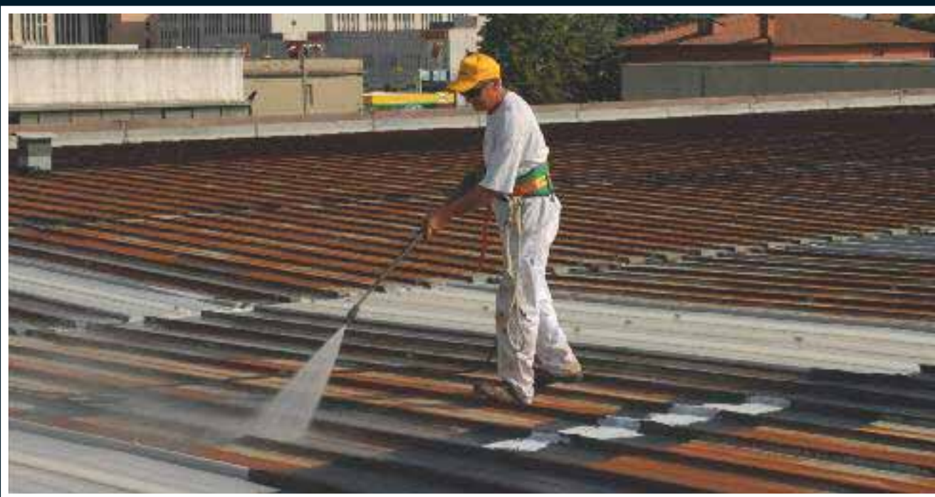
Prva faza: Čiščenje s pomočjo kompresorja in vode pod visokim pritiskom, da odstranimo rjo, umazanijo...
