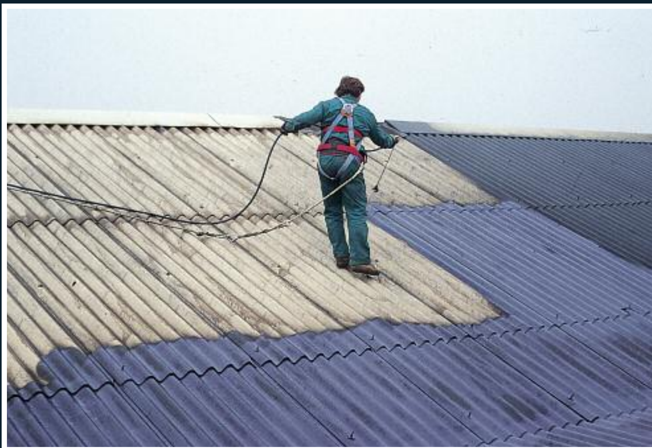
Obnova strehe s špricanjem
