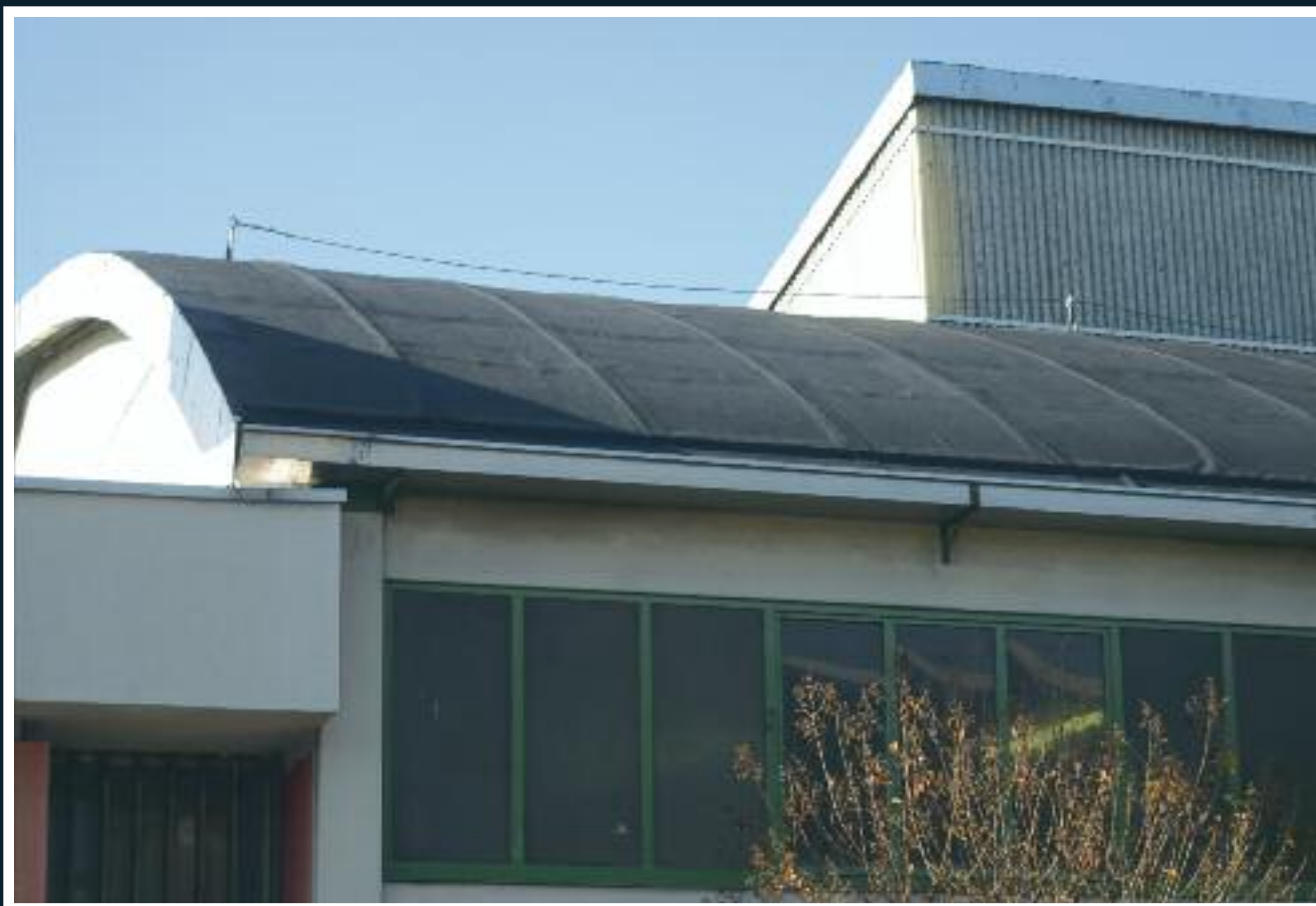
Obnovljena streha z Elastik-om
