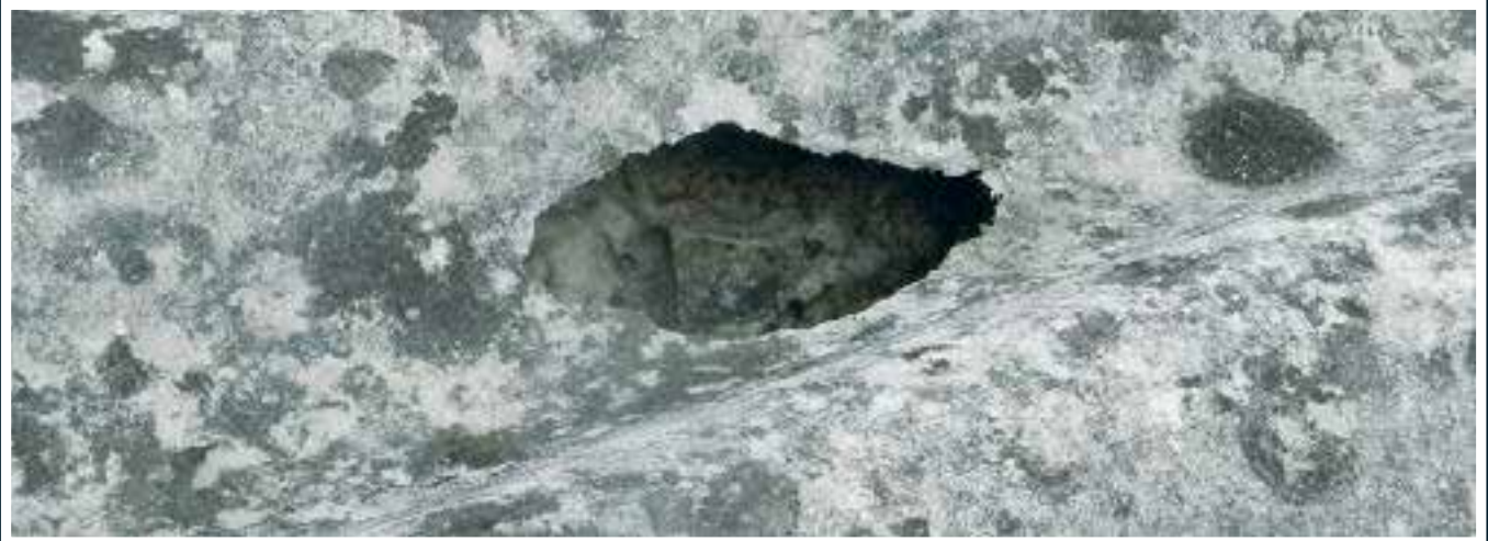
Résultat évident de la rupture de la couverture en fibre-ciment due à des chutes de grêle
