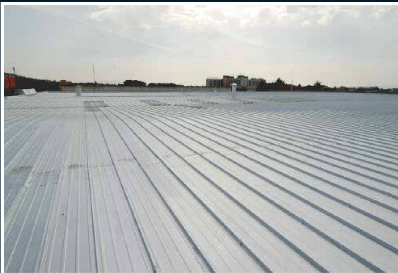
Aspect de la couverture métallique finie après le traitement réalisé avec une couche de vernis à l'aluminium type Allumisol appliquée 20 jours après la deuxième couche d' ElastiK (application par pulvérisation pour une consommation totale de 200 g/m 2 )
