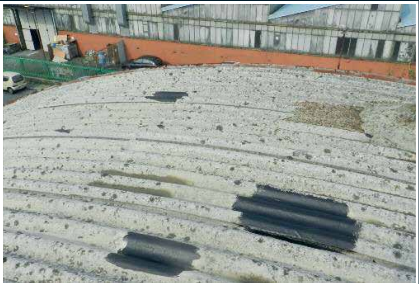
Résultat évident de la rupture de la couverture en fibre-ciment due à des chutes de grêle
