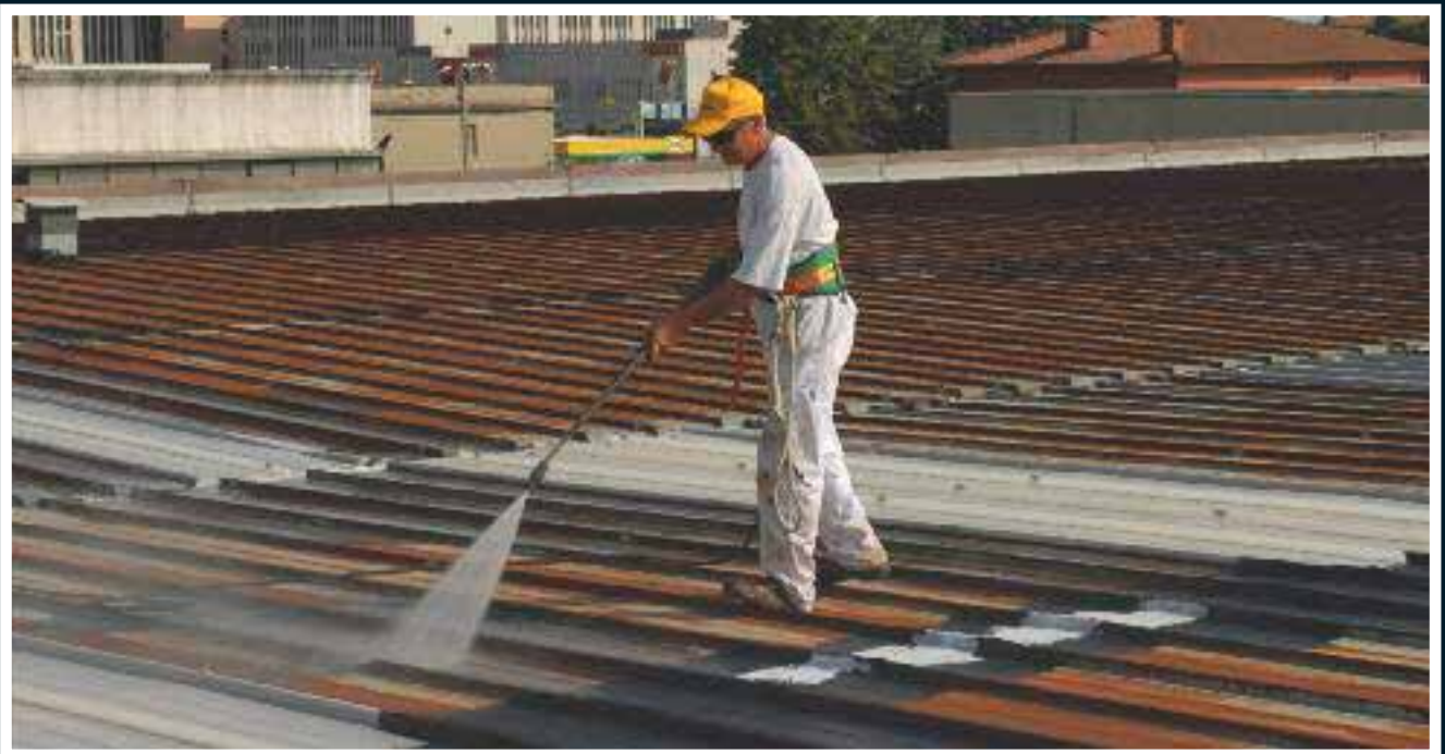
Première phase de nettoyage avec un nettoyeur à jet d'eau haute pression pour éliminer la rouille, la saleté, etc.
